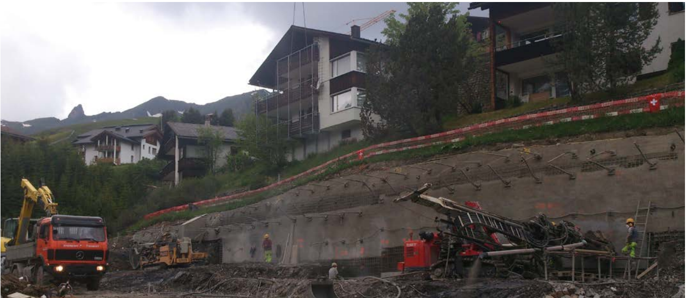
Arosa Schafisgaden excavation work
