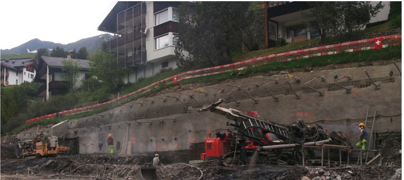
Arosa Schafisgaden excavation work
