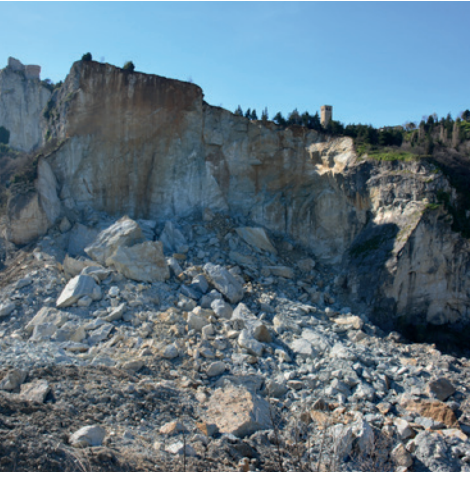
Deslizamientos de Maratea, Italia
