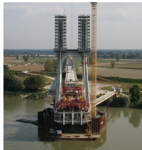
Puente sobre el río Po, Ferrocarril de alta velocidad de Milán a Bolonia - Italia
