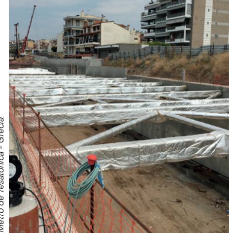
BH-Profile In-Place Inclínometer Metro de Tesalónica - Grecia
