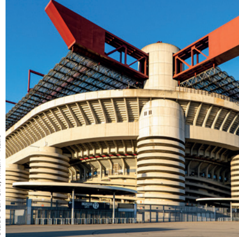
Surveillance dynamique du toit avec clinomètres. Stade San Siro, Milan - Italie
