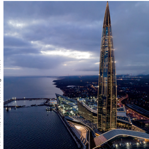
Surveillance des fondations et des bâtiments. Tour Lakhta, Saint-Petersbourg - Russie
