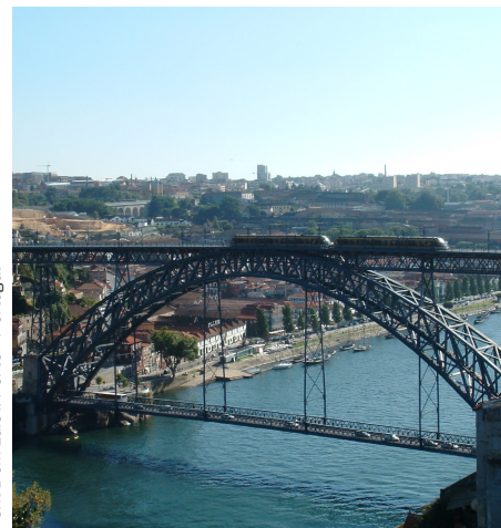
Pont Dom Luís I, Porto - Portugal
