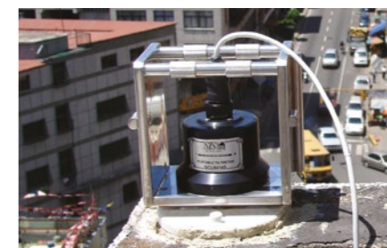
Misure su edificio con TILLI
