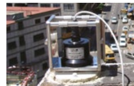
Misure su edificio con TILLI
