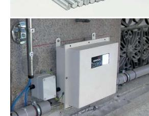
**نظام قياس الهبوط المتباين**
